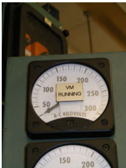
Fig. 15. Analog Single-Phase Voltmeter
